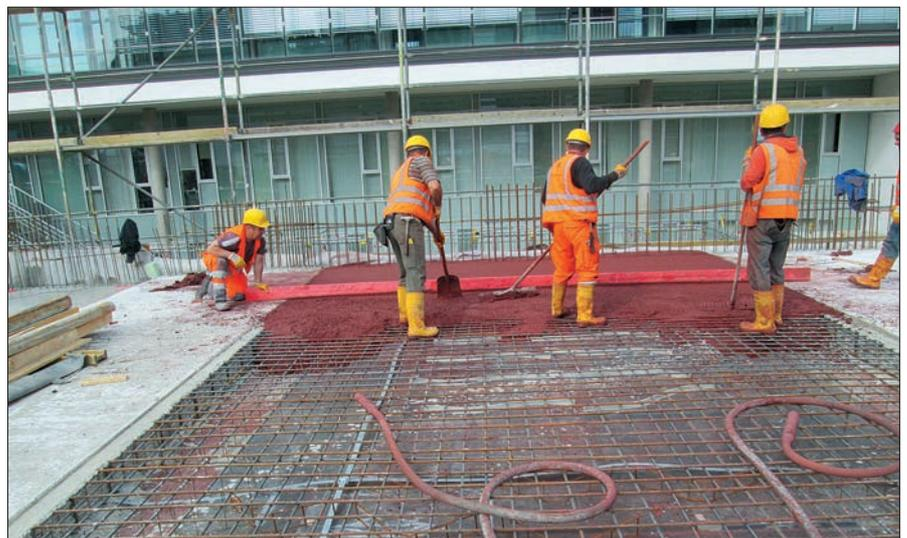
Der rote Schwerbeton wurde in exakt berechneten Wandstreifen, rund um die Tür und in einem Teil der Decke verwendet.
